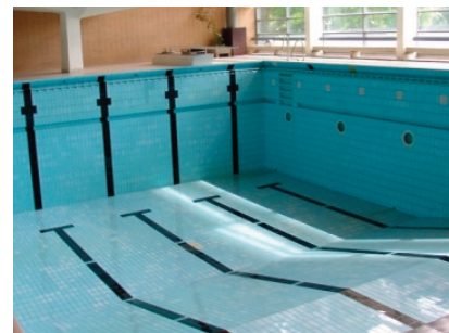
kein Wasser im Bad
