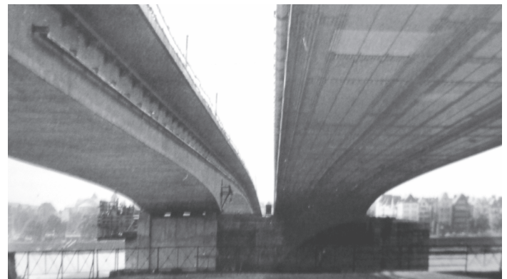
Deutzer Brücke, links Beton rechts Stahl, vor dem Zusammenschieben
